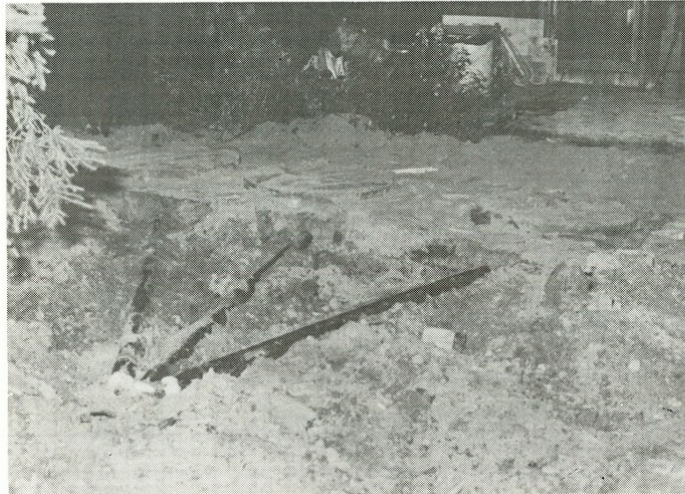
Bilder 4 u. 5.: Übersichtsaufnahmen der Betonruben zur Herstellung von Wasserstoff mit Ableitungssystem
