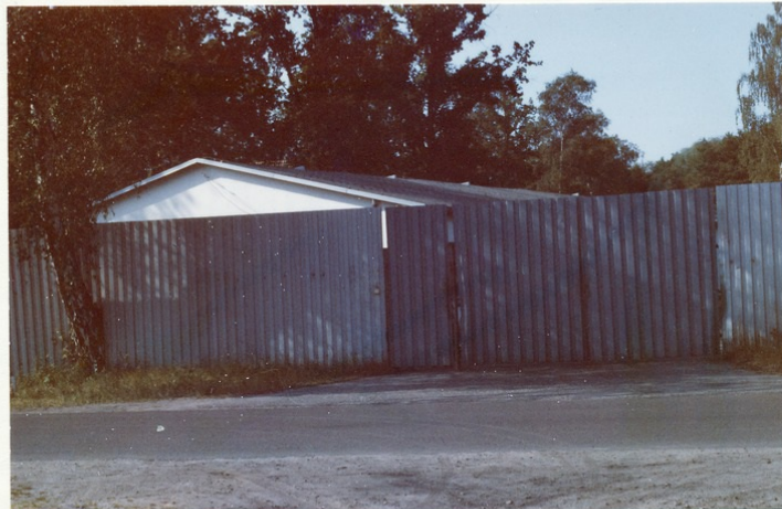
Ansicht der Eingangslösung zum gegenwärtigen Zeitpunkt
